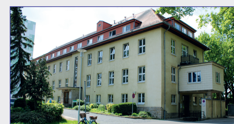
Haus 27 - Betriebsarzt, Audio Reha (CI), Akustikerservice, Schlaflabor (Dr. Trümper)
